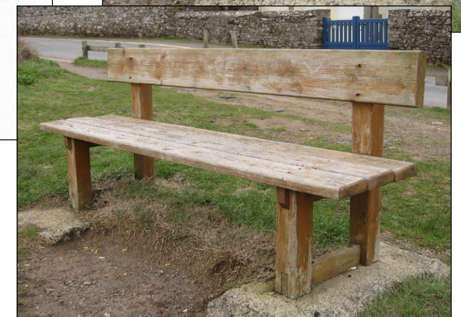
fixation du banc sur 2 dallettes béton coulées dans le sol en place : 80 x 30 cm et 20 cm d'épaisseur
