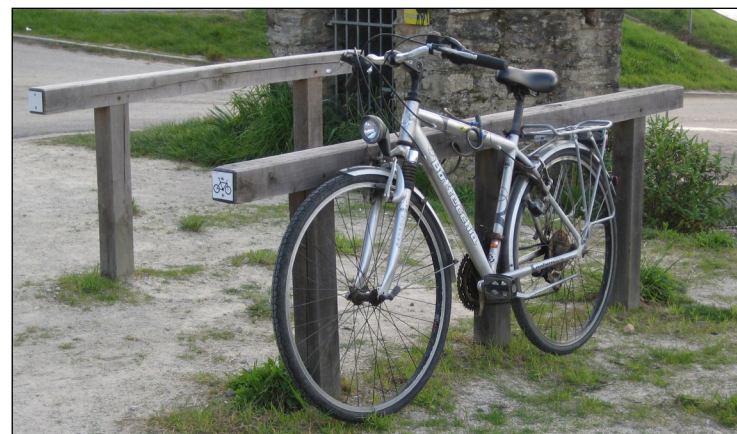
essence : chêne longueur : 2,20 m hauteur hors-sol : 0,70 m 3 poteaux de soutien section lisse et poteaux : 95 x 95 mm assemblage : cheville bois ou boulonnerie inox arasée/encastree
