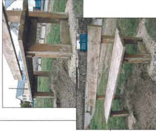
fixation du banc sur 2 dallettes béton coulées dans le sol en place : 80 x 30 cm et 20 cm d'épaisseur
