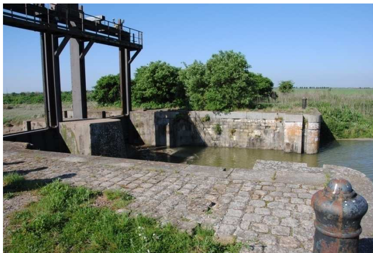
Photo 6 : Vue sur la partie amont de la tête aval de l'ancienne écluse (21-04-15)
