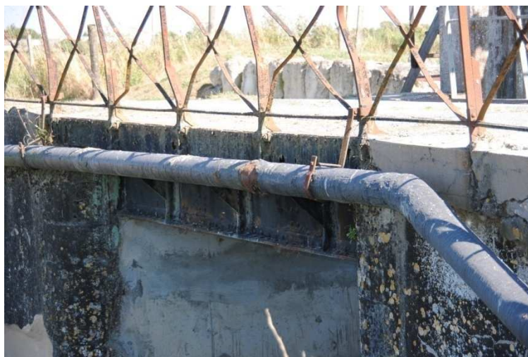
Figure 11 : Traverse acier du pont de franchissement du Russon de Champagné (22-07-15)
