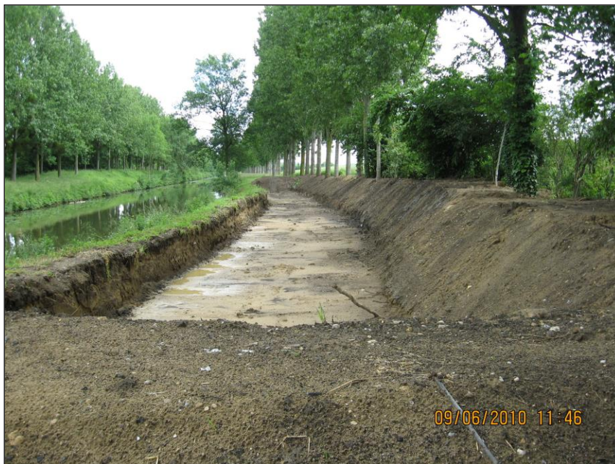
Fosse de ressuyage prête à recevoir les sédiments le long du canal de Noyen
