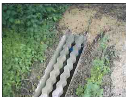
Passage busé de diamètre Ø 300, au niveau de la RD 42
