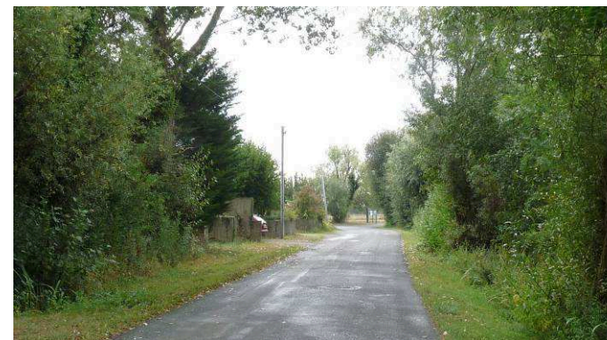
Chemin des Genêts – partie Nord : chaussée de 3.80 m + accotements enherbés
