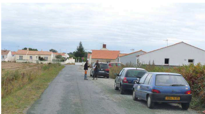
Chemin des Genêts – partie Sud : chaussée de 3.50 m + fossés et/ou accotement (9m d'emprise globale)
