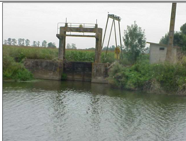
Vanne et station de pompage de Marans. De l'érosion au droit du Génie civil en bordure du cours d'eau
