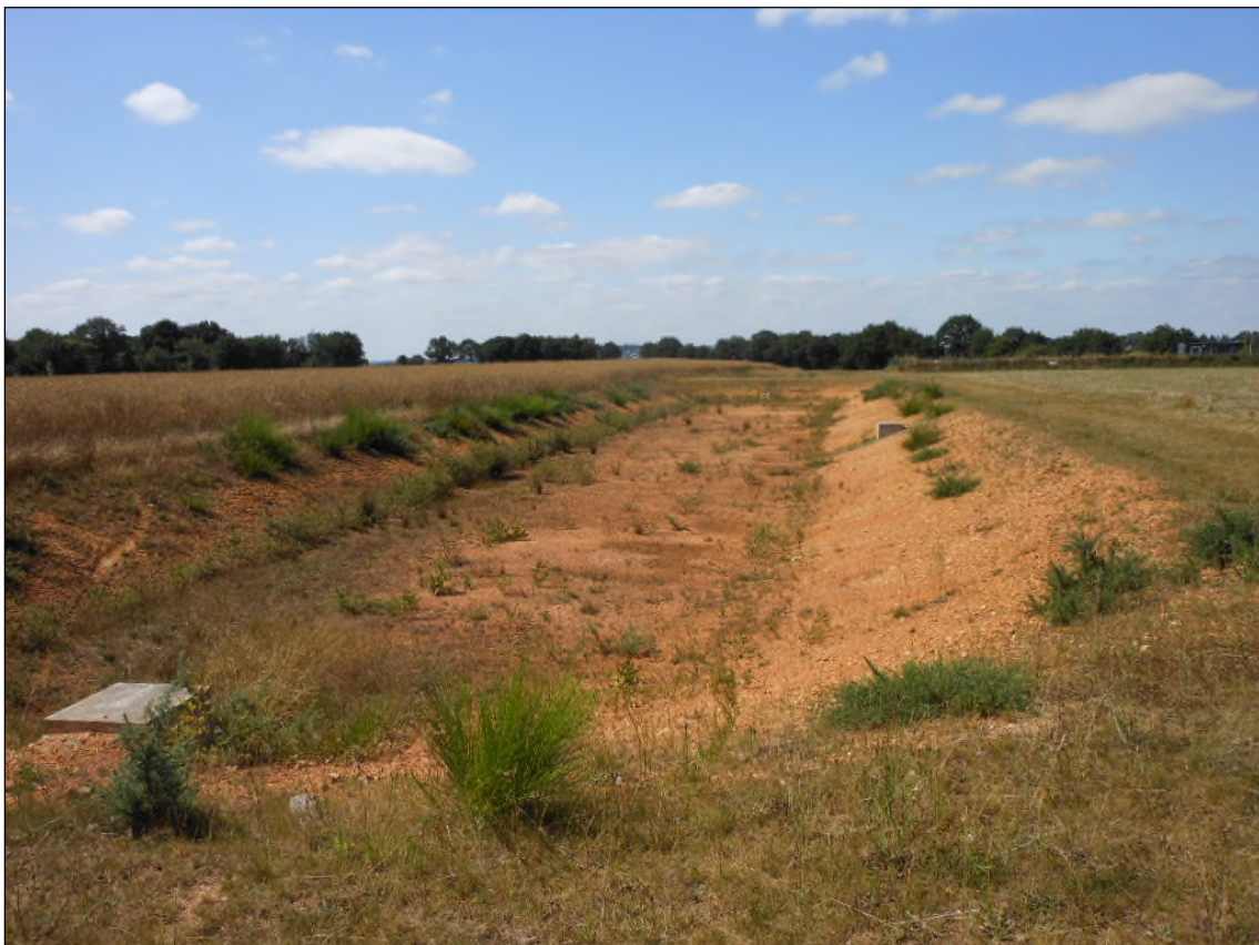
Ouvrages de régulation du SBV 4 – Bassin de 550 m³– Vue depuis le Sud des bassins
