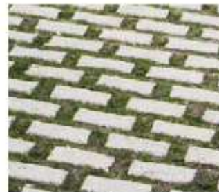
Pavage en béton avec ouvertures de drainage
