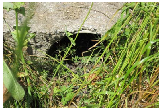
Conduite d'arrivée Ø 250mm PVC
