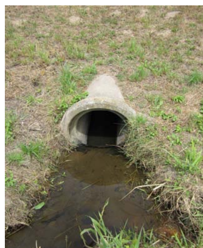
Sortie Ø 500mm Béton
