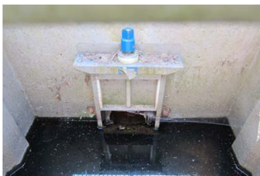
Ouvrage de régulation du débit l 30cm * h 20cm
