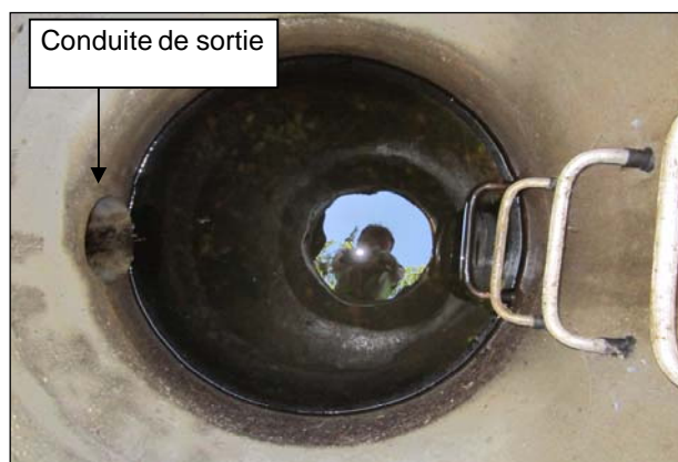
Vue intérieure du regard de sortie
