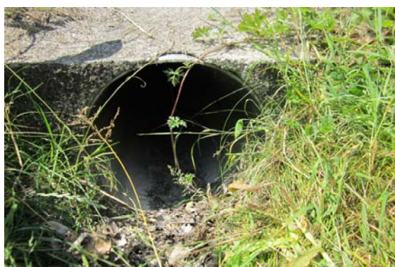
Conduite d'arrivée Ø 370mm PVC
