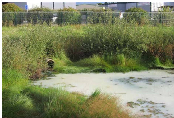
Arrivées Ø 500mm Béton
