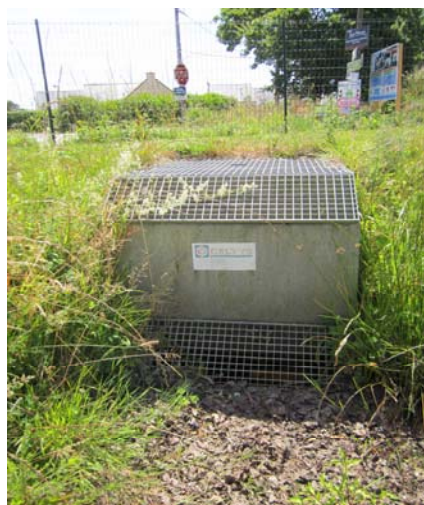
Ouvrage de régulation et surverse
