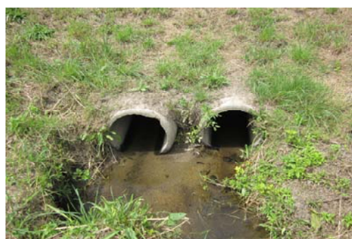
Les deux arrivées Ø 500mm Béton
