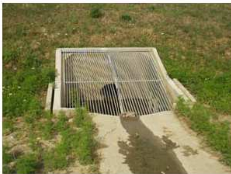
Figure 21 : Grille de protection sur ouvrage de sortie
