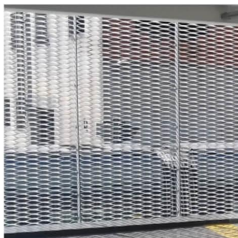
Clôture en métal déployé acier, profils structurants acier
