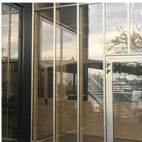
Murs rideaux, profils aluminium sans capotage
