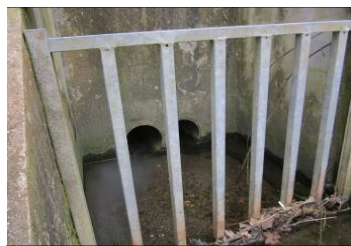
Ouvrage de régulation: 2 Orrifices d'ajustages de DN200mm et canalisaiion de sortie DN600mm
