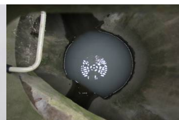
Présence d'un écoulement blanchâtre lors de la visite de terrain (mauvais branchement ou rejet dans le réseau pluvial?)
