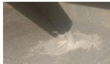
Reprise de passages de canalisations
