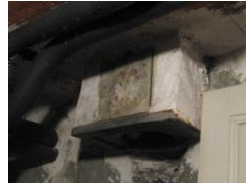
Départ de l'ancien conduit dans la cave
