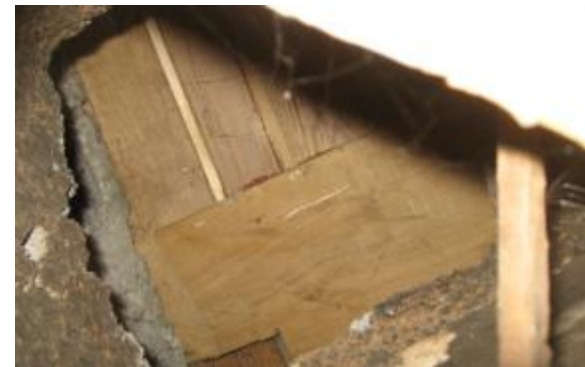
Vue intérieure du boisseau : Traversée de la dalle connectée à la lame d'air sous le plancher bois
