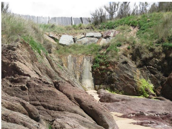
*Illustration 68 - Lutte contre l'érosion par bétonnage et enrochement en fond d'indentation*
