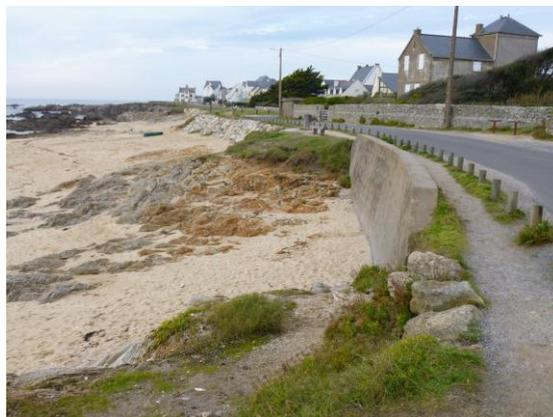
*Illustration 39 – Mur et enrochement réalisé depuis 2004 au niveau de la Baie du Crucifix au Croisic (visite de terrain du 08/11/2012)*
