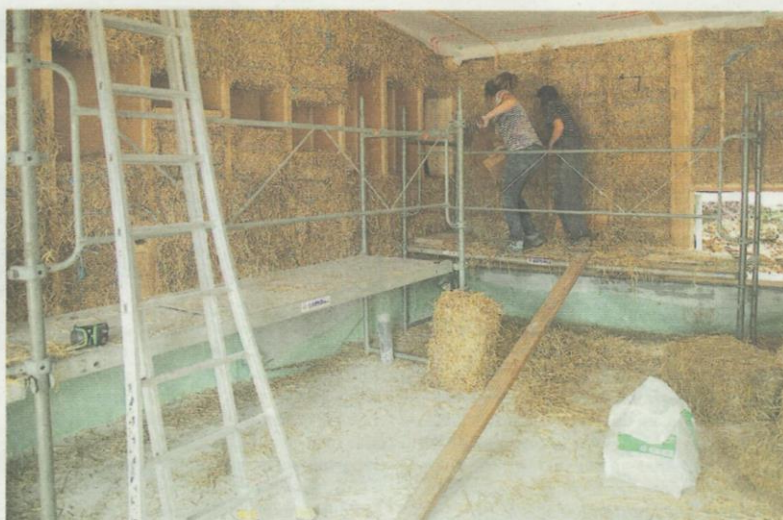
> L'école du Quistinic construite en paille. Un très bon isolant qui permet la construction de bâtiments passifs. Et contrairement aux idées reçues, elle résiste très bien au feu et les rongeurs ne s'y intéressent pas.
