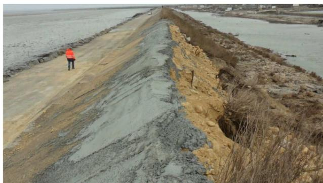
Illustration 98 : Plaquage béton sur rechargement en brut de carrière d'une digue en terre (Bouin, Vendée) - CETEO-LRB
