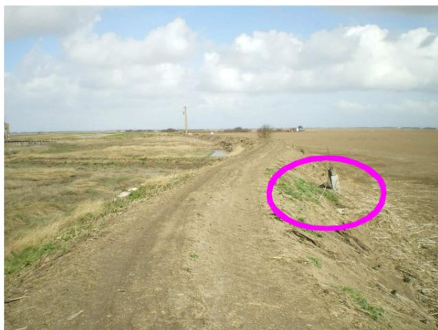
Illustration 49 : Vanne gérant les échanges hydrauliques entre les polders (à droite de la digue) et la baie (à gauche) (Anse de l'Aiguillon, Vendée) - CETEO-LRA
