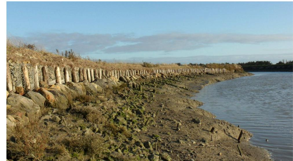
Illustration 37 : Digue en terre avec protection de pied en petits enrochements bloqués par grillage et pieux + enrochements pare-fouille (Beauvoir-sur-Mer, Vendée) - CETEO-LRB
