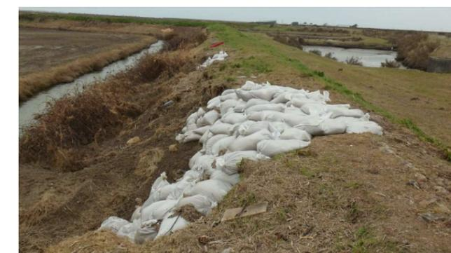
Illustration 96 : Réparation d'un affouillement par dépose de sacs de sable (La Barre-de-Monts, Vendée) - CETEO-LRB
