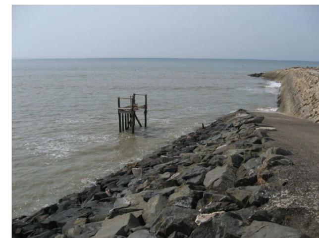
Illustration 46 : Cale d'accès à la plage et de mise à l'eau avec protection en enrochements (L'Aiguillon-sur-Mer, Vendée) – CETEO-LRA
