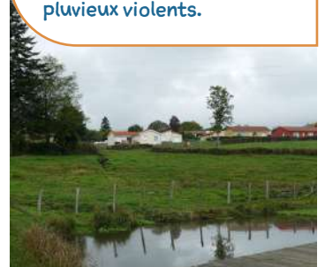
Mare collectant les eaux pluviales en aval de l'opération - Matour (71)
