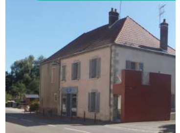
Réhabilitation d'un bâtiment en front de rue avec un local commercial en rez-de-chaussée - Marmagne (71)
