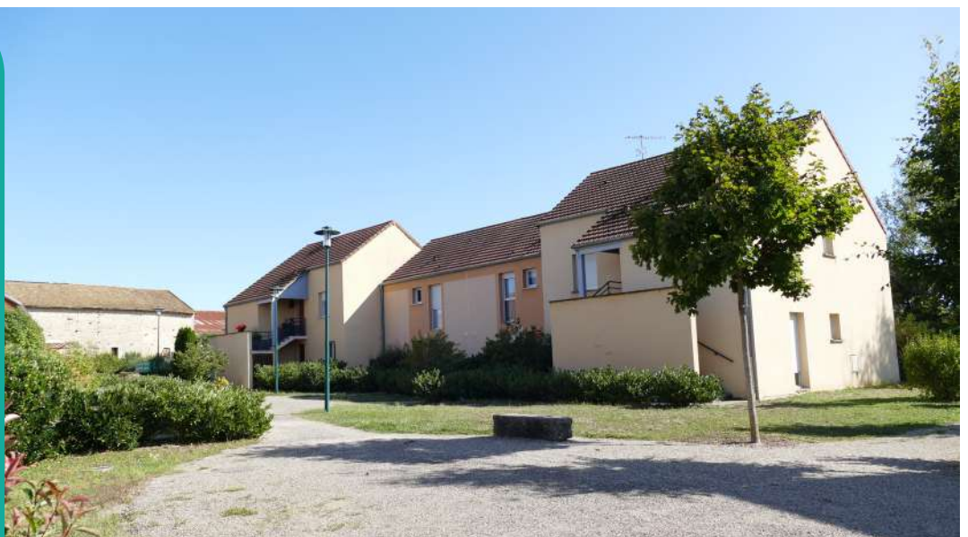
Sainte-Marie-la-Blanche (21) - Des espaces communs densément plantés sont traversés par des liaisons douces. Cette ambiance jardinée favorise une meilleure acceptation de la densité en assurant l'intimité des logements et des espaces extérieurs privés.
