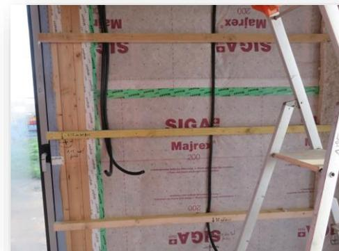
Bonne mise en œuvre de la membrane d'étanchéité
