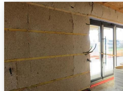
Isolation en mur avec du Biofib'trio 45 mm
