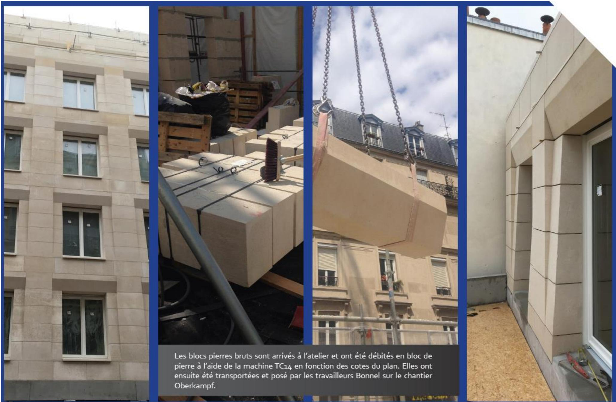
Les blocs pierres bruts sont arrivés à l'atelier et ont été débités en bloc de pierre à l'aide de la machine TC14 en fonction des cotes du plan. Elles ont ensuite été transportées et posées par les travailleurs Bonnel sur le chantier Oberkampf.
