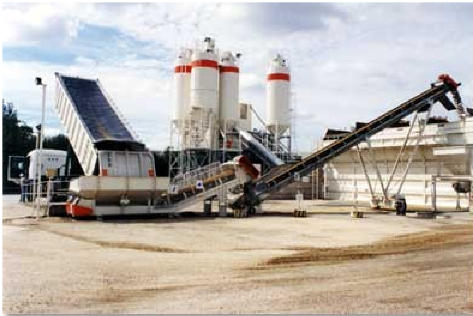
Centrale à béton (photo UNICEM)
