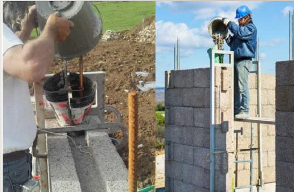
Remplissage des poteaux avec un béton conforme aux prescriptions de l'ATEX 2482 et du bureau d'études :
