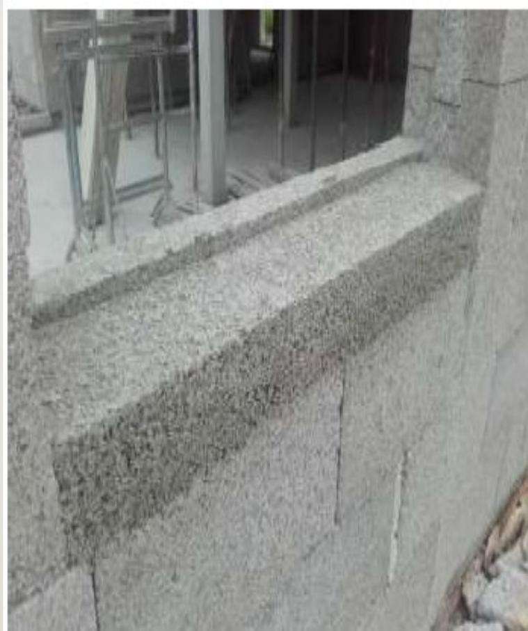
Astuce de chantier : vous pouvez réaliser un appui de fenêtre en béton de chanvre banché.
