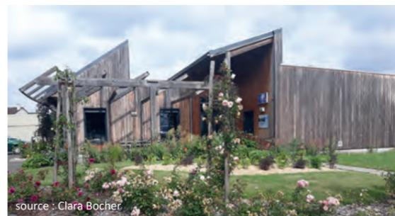
Sur une structure en ossature bois, les murs intérieurs du bâtiment administratif sont conçus sur la base d'un treillage de roseaux ou saule-osier rempli en terre crue. Les murs extérieurs sont isolés en panneaux de fibre de bois, tissu et papier recyclés.
