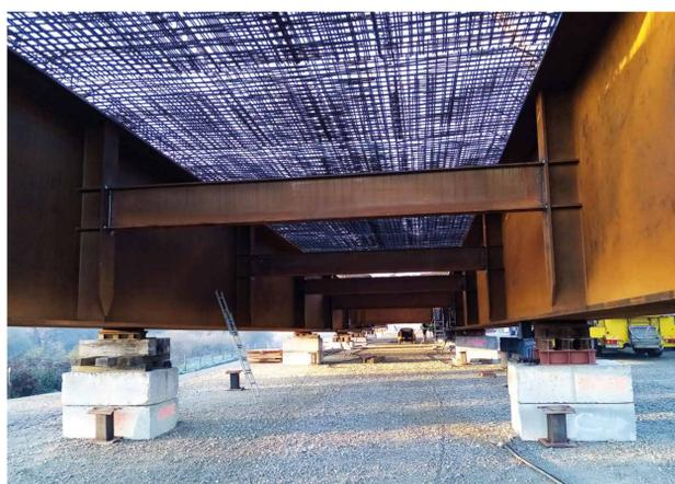
Charpente métallique en cours d'assemblage sur site.
