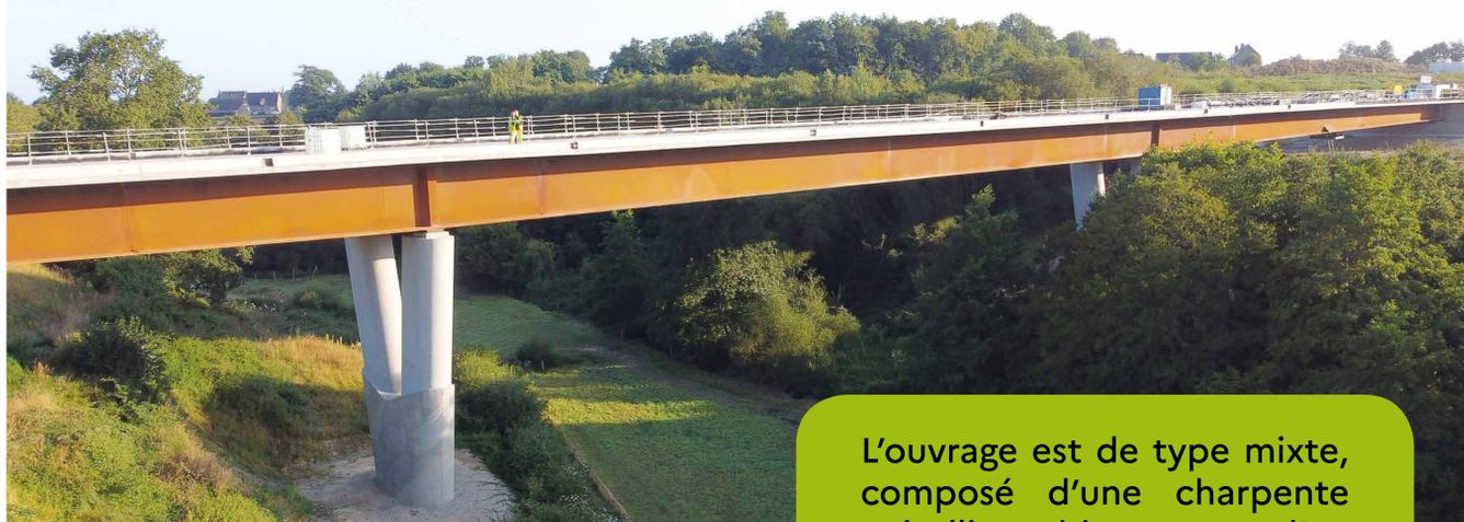
L'ouvrage est de type mixte, composé d'une charpente métallique bipoutre et d'un tablier en béton appuyé sur deux piles. Sous le viaduc, le tirant d'air atteint environ 13 m au droit du ruisseau de la Villette.
