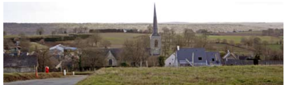
Le village de Vautorte enfoui au creux du vallon. (Mayenne)
