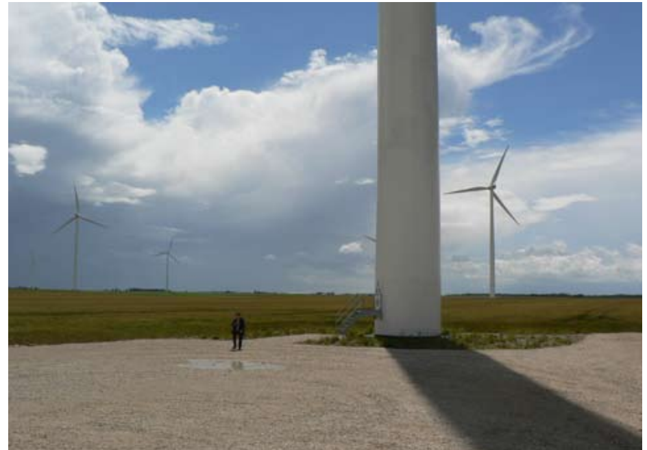
Eviter les vastes aires minérales en régaland la terre végétale en fin de chantier
