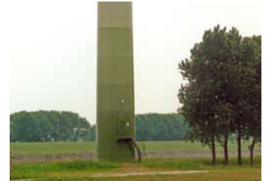
Les dégradés de couleur en pied de mât produisent un effet artificiel et sont à déconseiller
