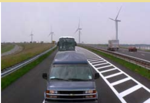
Un parc à l'implantation bien lisible : le long d'une voie autoroutière, un alignement strict d'éoliennes aux écartements équidistants
