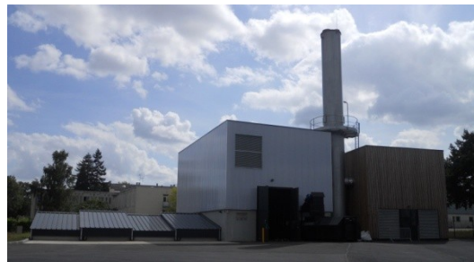
Illustration 3: chaufferie de la ville de Chateaubriant avec silo semi-enterré
