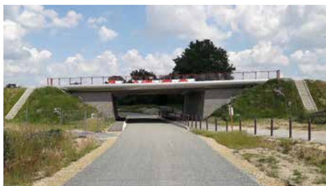
Rétablissement de la voie communale de la Conillère
