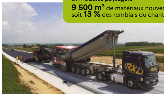
Mise en œuvre d'enrobé
