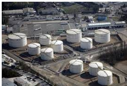
Stockage de carburant
