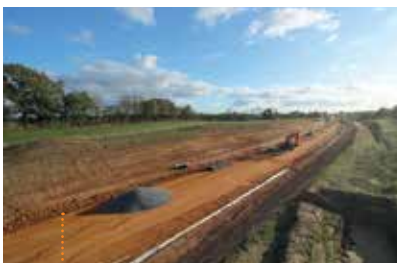
Travaux de mise en place de l'assainissement définitifs
