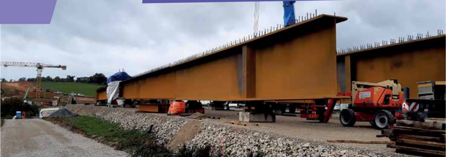
Viaduc de la Villette : la charpente en cours d'installation
