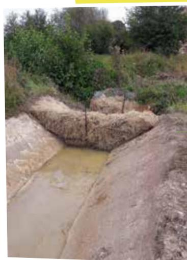
Déviations du ruisseau de la Farinelais - Filtre à paille servant à filtrer les eaux pompées dans le ruisseau après la pêche de sauvegarde.
