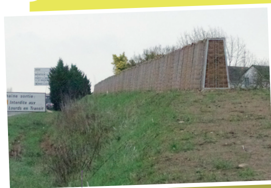
Merlon rehaussé Février 2018
