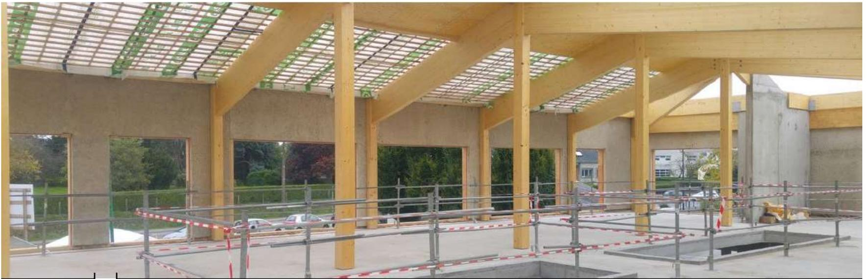
La préfabrication : panneaux Bois-Béton de chanvre
