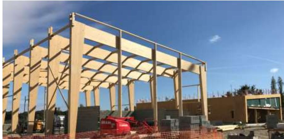
*Structure charpente **bois** lamellé collé et bois massif*
