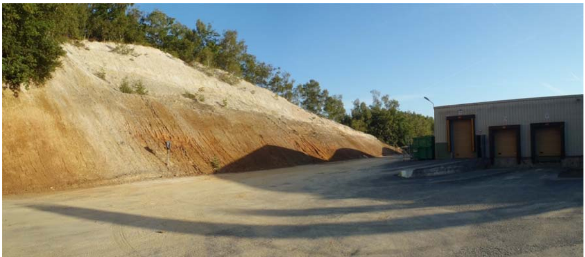
Illustration 24- Vue du talus Nord, dont les poussières recouvrent la chaussée.
