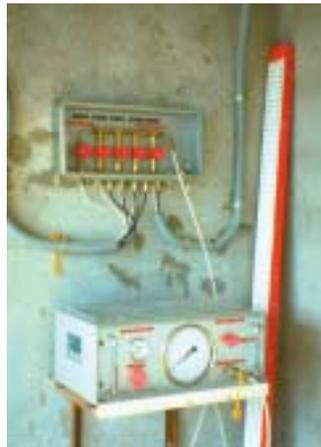
**Photo 7b.** Tableau de mesure des pressions interstitielles (barrage de Moulin-Papon, Vendée).
