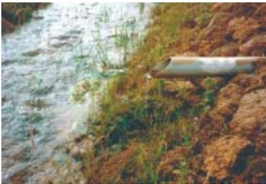
**Photo 3.** Exutoire d'un drain permettant des mesures par empotement depuis le fossé de pied (barrage de Douma, Burkina Faso).
