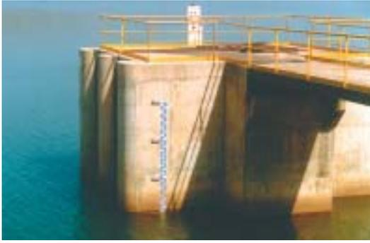
**Photo 1.** Échelle limnimétrique installée sur une tour de prise (barrage de Douma, Burkina Faso).
