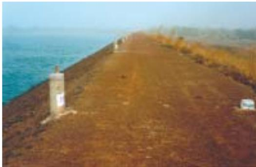
**Photo 6.** Protection de tête sur une ligne de piézomètres (remarquer également la borne pour le suivi topographique) (barrage de Douma, Burkina Faso).
