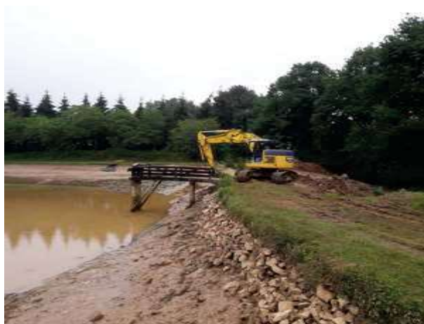
Reprise du profil du barrage ⇒ travaux substantiels
