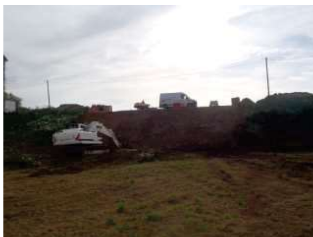
Travaux de décapage du parement amont avant la pose d'une géogridde recouverte de terre végétale suite à l'EISH – Barrage de Beffou (22) ©DREAL Bretagne - Olivier ORHANT - octobre 2023
