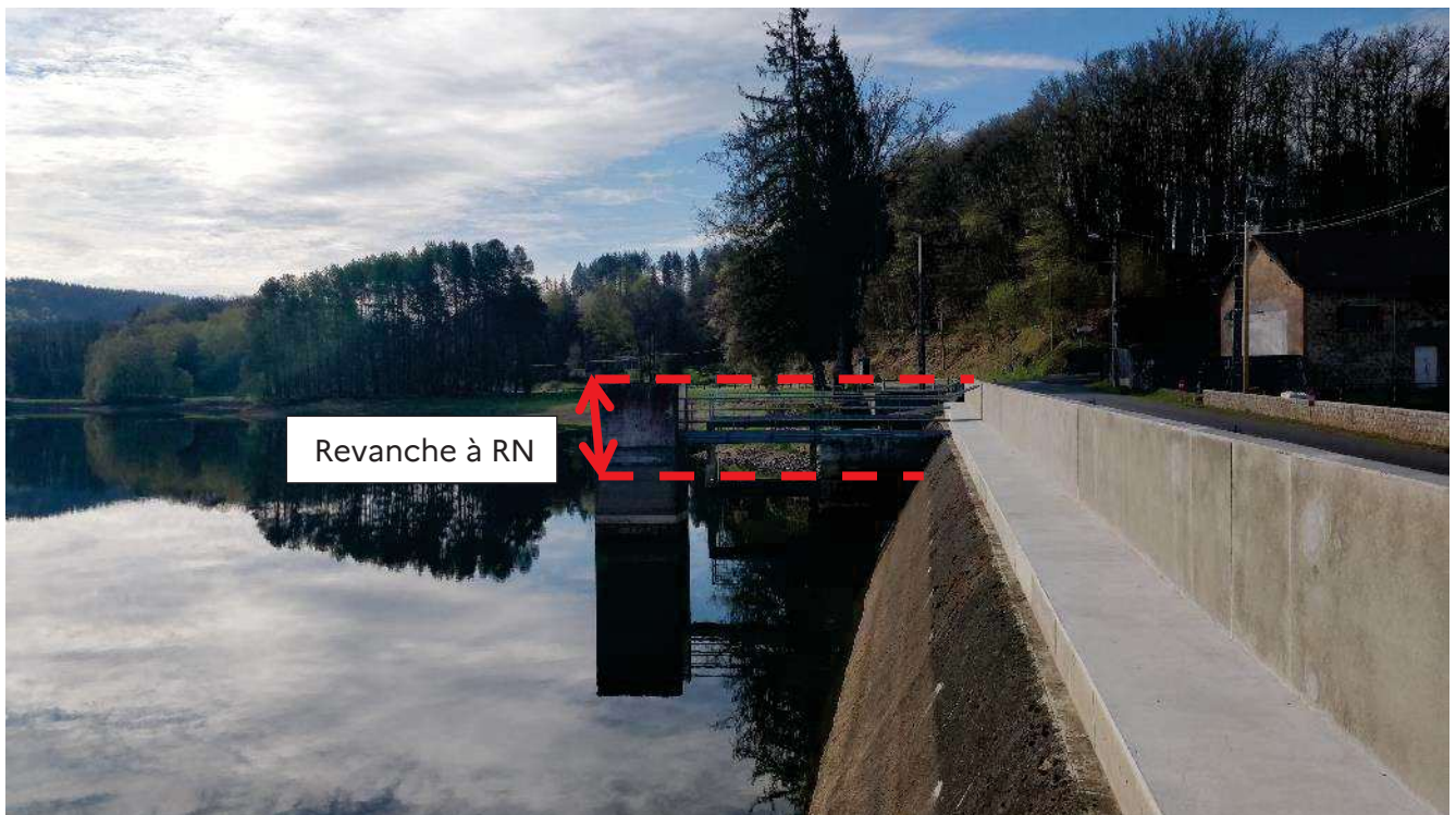
Barrage de la Crouzille (87) – barrage de classe C équipé d'un mur pare-vagues © DREAL Nouvelle-Aquitaine – Xavier Ducreux
