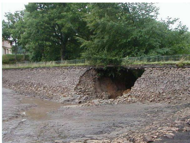
*Rupture après érosion interne autour d'une conduite traversante*
