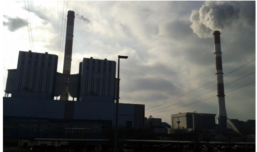
Centrale électrique de Cordemais ( fioul et charbon )
