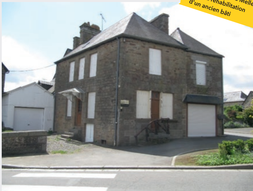
Avant la réhabilitation
