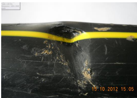
barre à mine / canalisation PEHD gaz MPB
