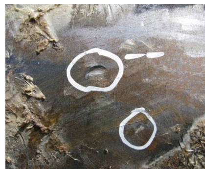
pioche / canalisation acier gaz HP
