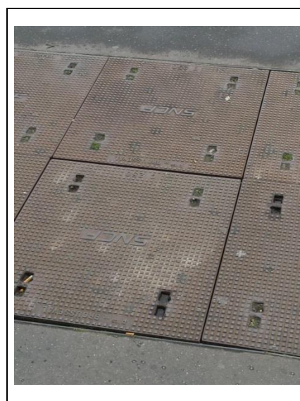
Installation électrique de gare
