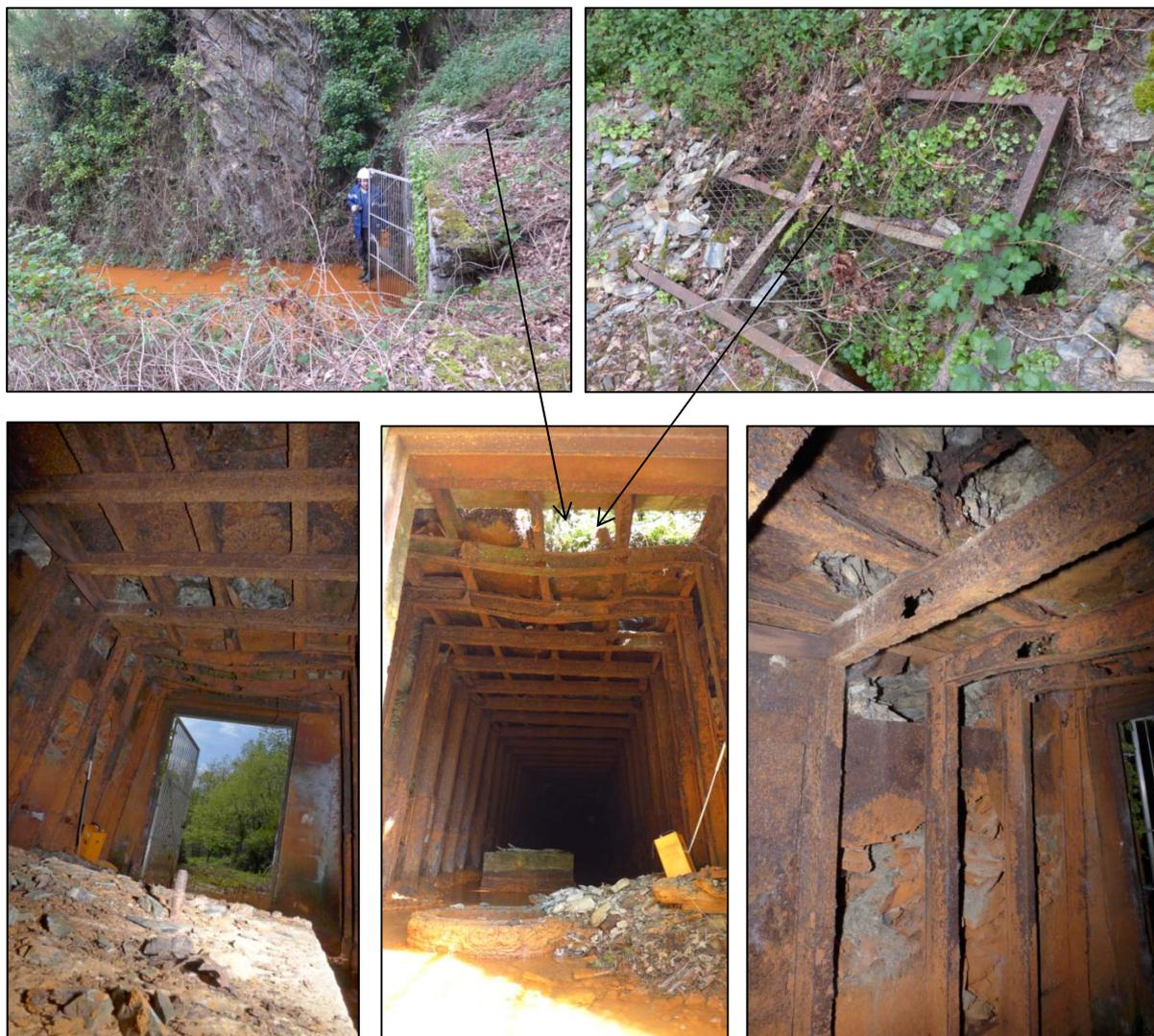
**Figure 22 : Vues des dégradations du soutènement à l'orifice du TB de la BONDRAIRIE**
