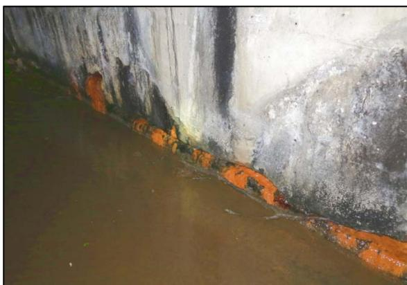
**Corrosion béton base piédroit droit (PM40 et PM78)**
