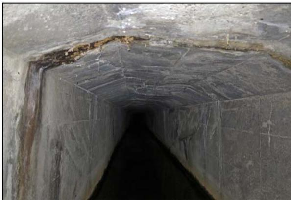
**Corrosion fers aux jointures de reprise de bétonnage, PM 122**
