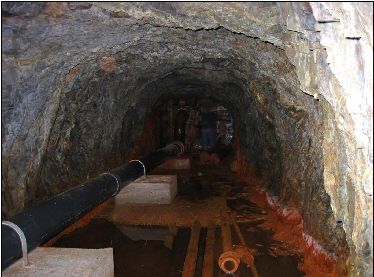
**Figure 20 : Vues de l'état 2003 du TB de la BONDRAIRIE, conduite PVC et vanne en sortie de galerie (GEODERIS)**
