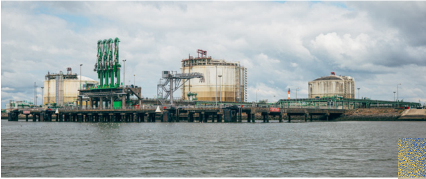
Terminal méthanier Elengy à Montoir de Bretagne
