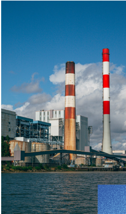
Centrale thermique EDF à Cordemais
