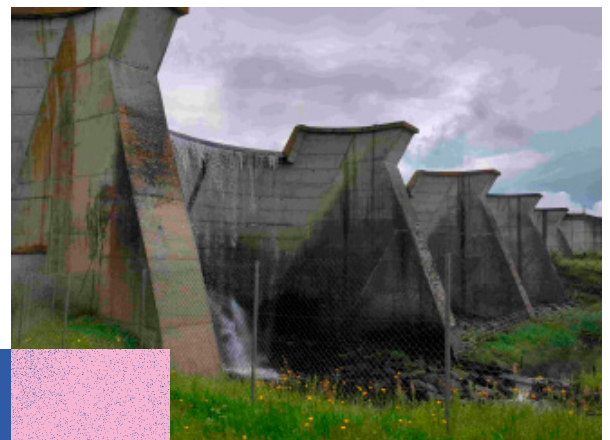
Barrage de Verdon
