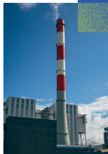
Centrale thermique EDF à Cordemais
