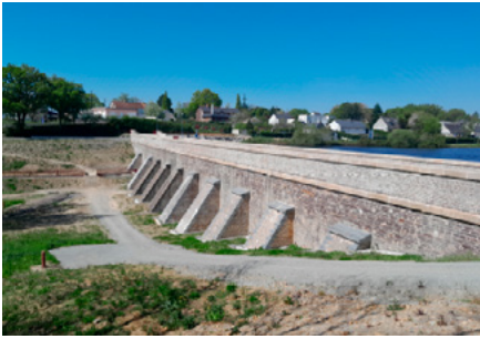
Barrage de Vioreau requalifié (c) Département de Loire-Atlantique
