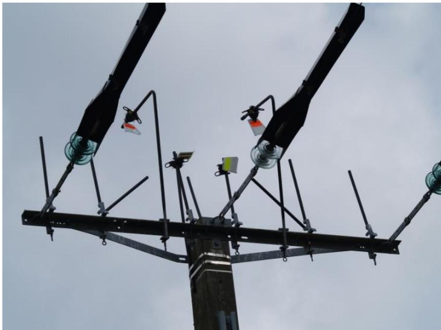
*Figure 21 : Dispositif installé sur un poteau électrique pour empêcher l'oiseau de revenir nicher après le déplacement de son nid (2012), avant l'adoption de l'anémomètre par Enedis Poitou-Charentes (Nicolas GENDRE / LPO)*
