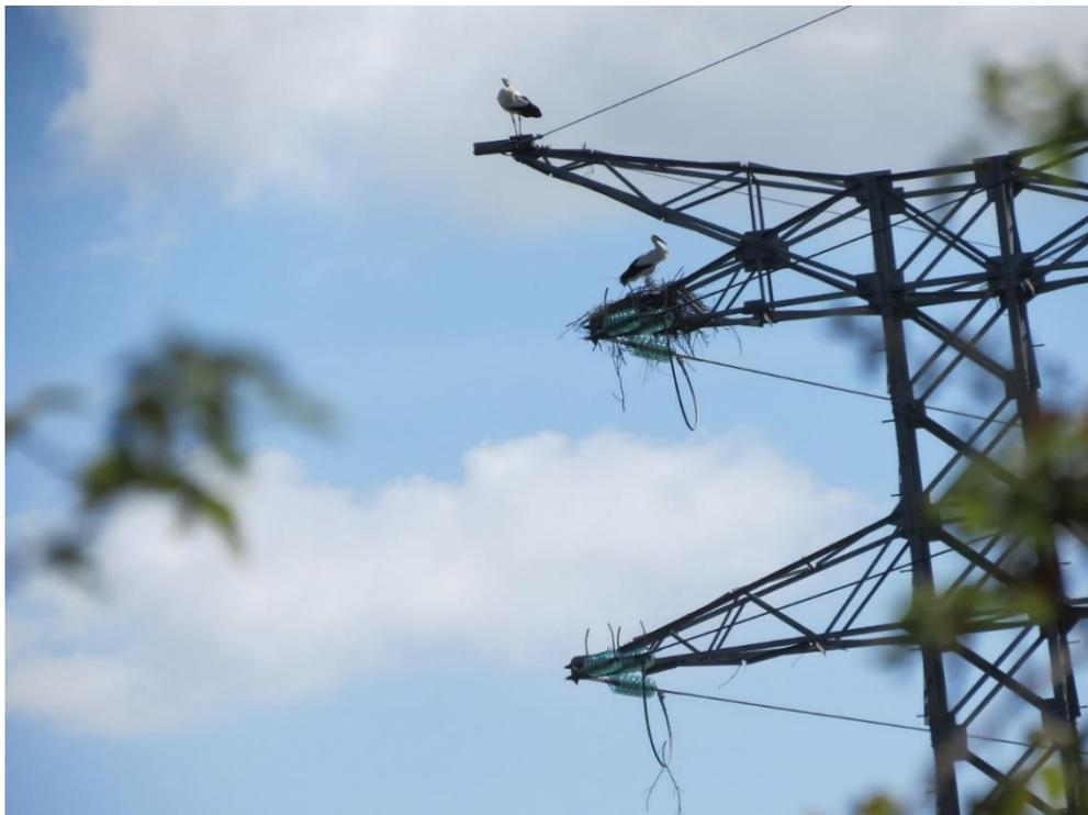
Figure 49 : Exemple d'un nouveau nid de Cigogne blanche en construction sur un pylône RTE avec de nombreuses branches tombant sur les phases en dessous, pouvant provoquer des microcoupures. Avril 2023 - Secteur de Saintes - Charente-Maritime (Nicolas GENDRE / LPO).
