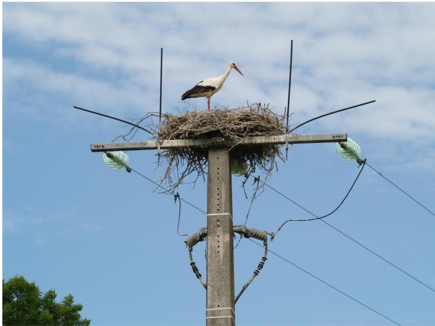
*Figure 20 : Cierges utilisés jusqu'en 2012 par Enedis Poitou-Charentes.
