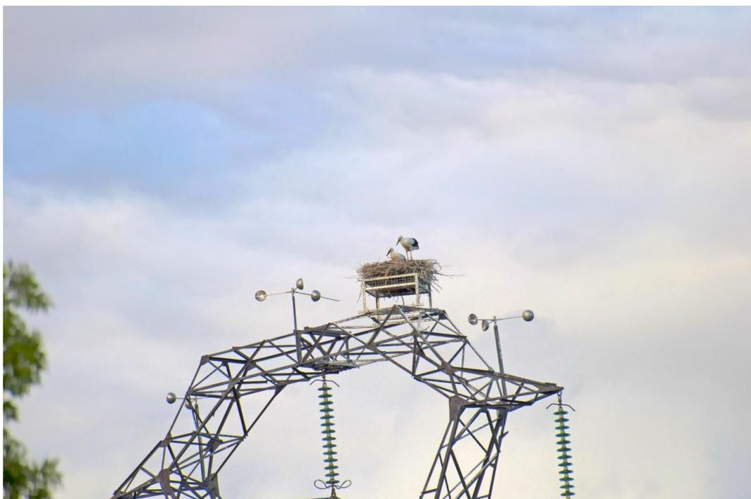
*Figure 45 : Plateforme sécurisée sur pylône RTE, avec les anémomètres installés. Les plateformes sont désormais surélevées pour permettre les travaux de maintenance (par exemple, travaux de peinture) sans toucher au nid (Cécile ROUSSE)*
