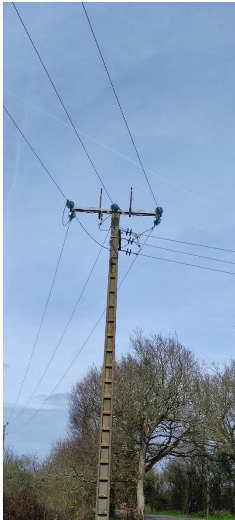
Figure 32: Pose de dispositif anti-nidification le 22 mars 2023, où par chance, le couple de Cigogne blanche s'est installé ensuite sur le réseau RTE. Ce dispositif n'est pas optimal pour empêcher la Cigogne blanche de nicher et peut avoir l'effet inverse. Installation à Braz à Montoir (44) (ACROLA).
