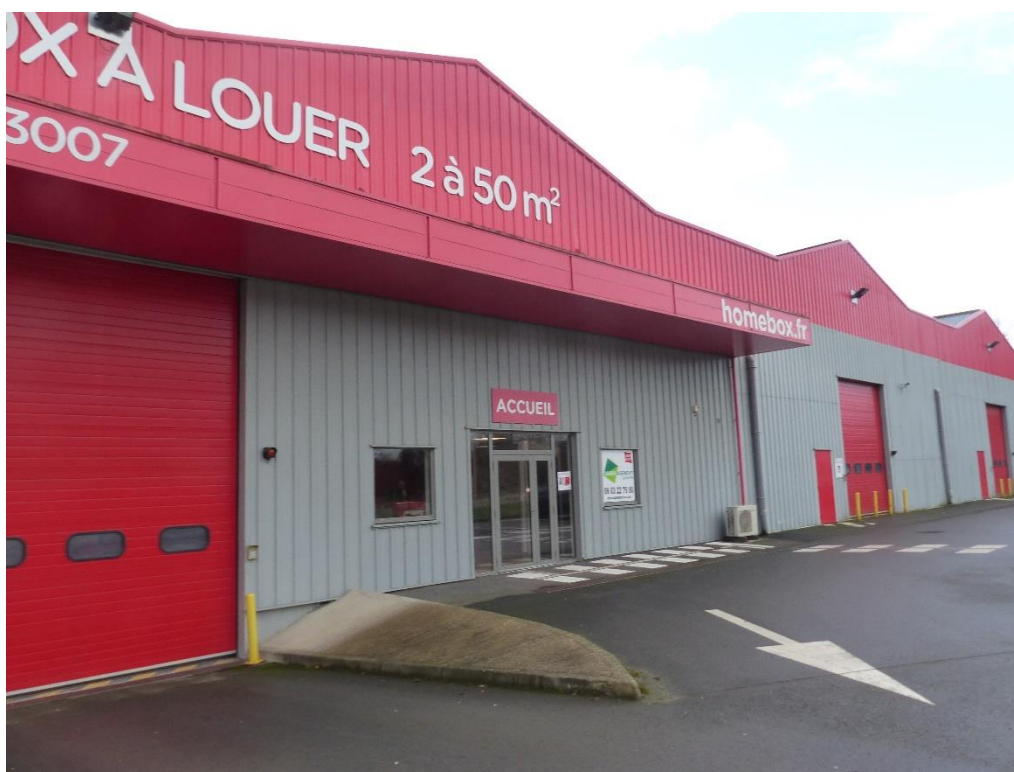
Figure 8 : Entrepôt actuellement exploité
