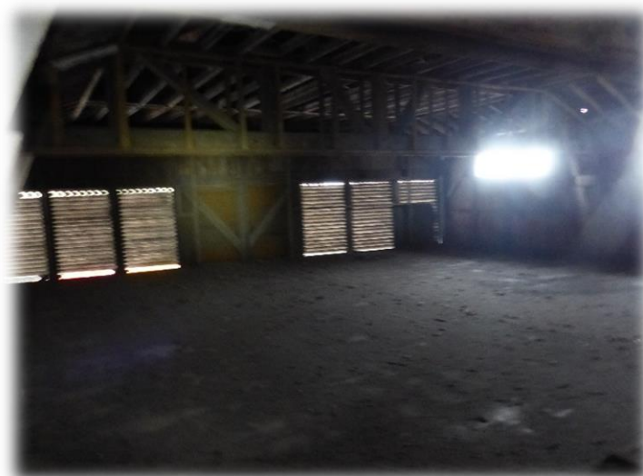
Figure 14 : Vue du grenier potentiellement favorable aux chiroptères
