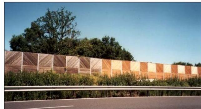
Figure 9 : Exemple de mur anti-bruit en bois
