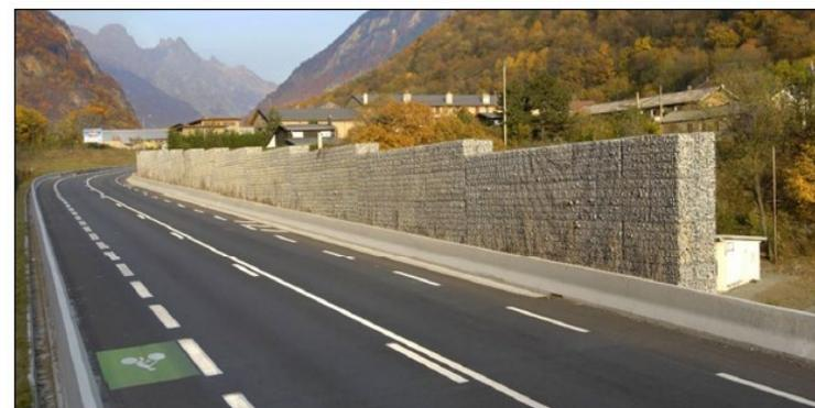
Figure 10 : Exemple de mur anti-bruit en gabions
