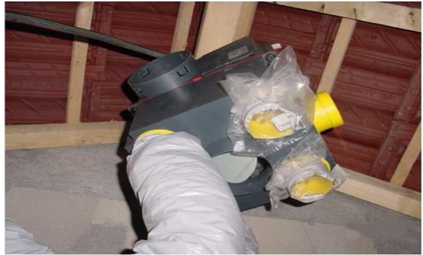
Rejet d'air vicié non raccordé
