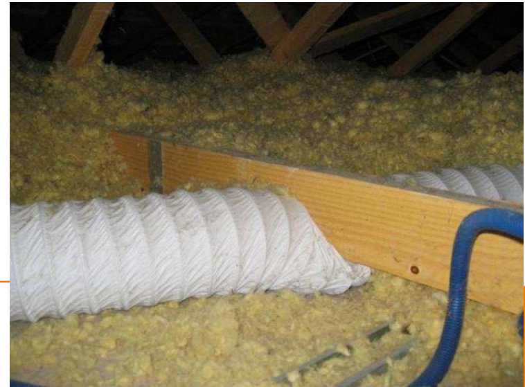
Gaine d'extraction pincée
