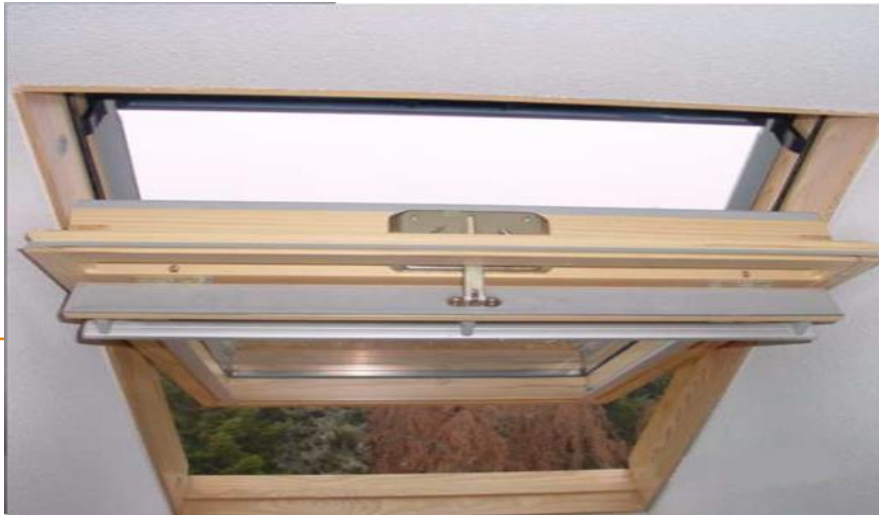
Entrée d'air non permanente
