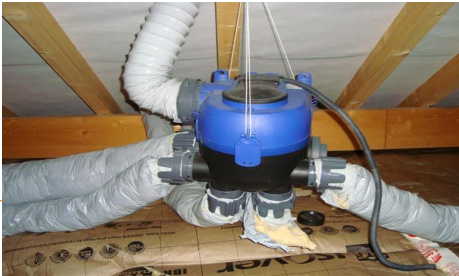
Gaines mal raccordées
