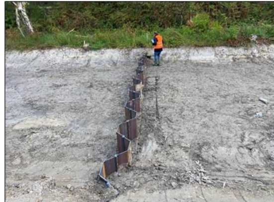
Figure 4 : Site du Bois Vert. Enrochements (en haut à gauche), pelle mécanique enlisée (en haut à droite), piste périphérique et curage (en bas à gauche), rideau de palplanches (en bas à droite).
