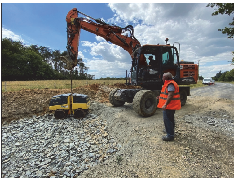
Figure 9: Compactage des remblais.
