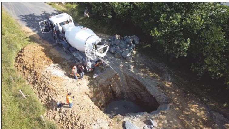
Figure 8 : Coulage de la première toupie de béton.
