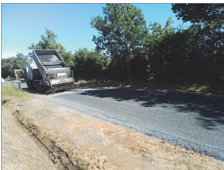
Figure 10 : Réalisation de l'enduit bicouche.
