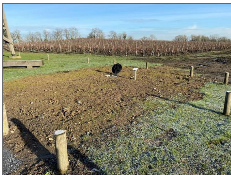
Figure 11 : Comblement intégral et regard de contrôle des remblais du puits Malécots II.
