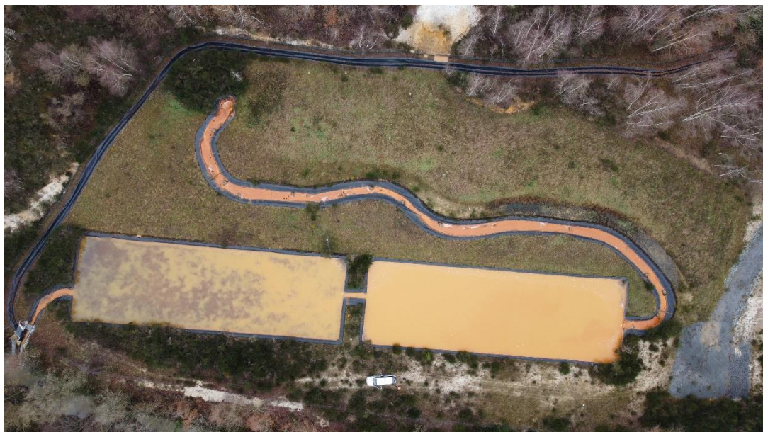
Figure 12 : Saint-Pierre-Montlimart - Vue des lagunes en décembre 2023.
