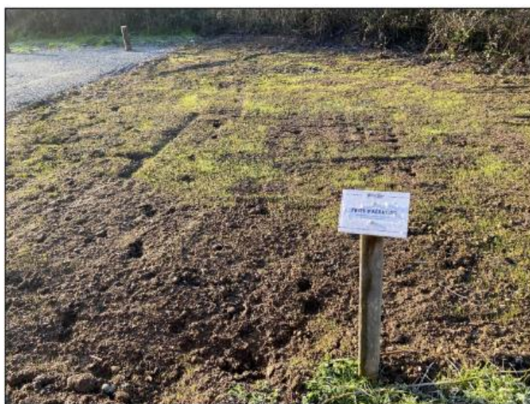
Figure 10 : Comblement intégral du puits d'aération et engazonnement.
