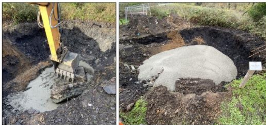
Figure 9 : Réalisation du bouchon en béton cyclopéen du puits d'aération.
