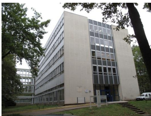
Figure 2 : Bureaux de l'UTAM Centre-Ouest (BRGM, Orléans).
