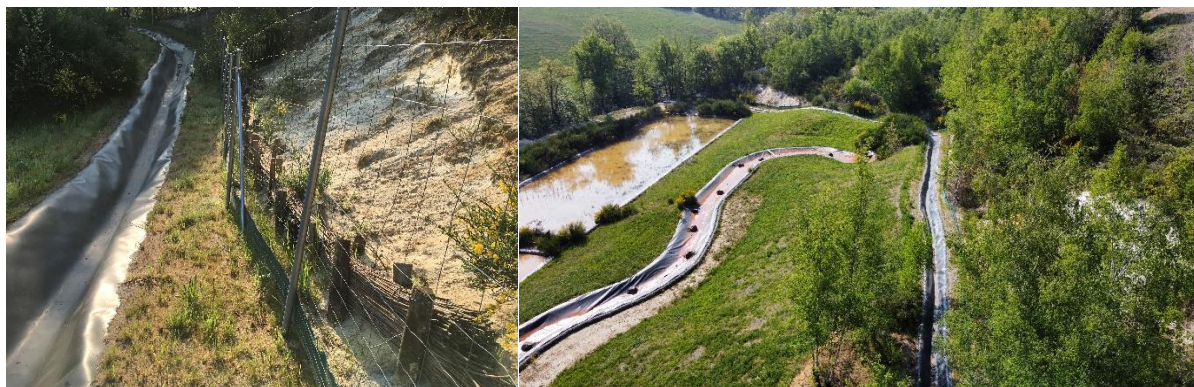
Figure 15 : Saint-Pierre-Montlimart (mai 2022) - À gauche, fascines et bionattes végétalisées protégeant le fossé de l'ensablement. À droite, suivi par drones des talus végétalisés et du fossé amont.
