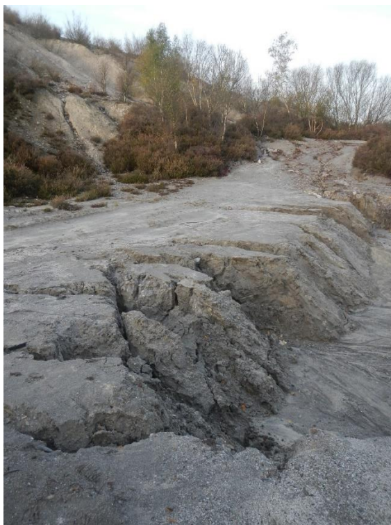
Figure 5 : Érosion de la piste au pied du terril conique.
