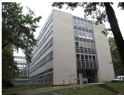
Figure 2 : Bureaux de l'UTAM Centre-Ouest (BRGM, Orléans)
