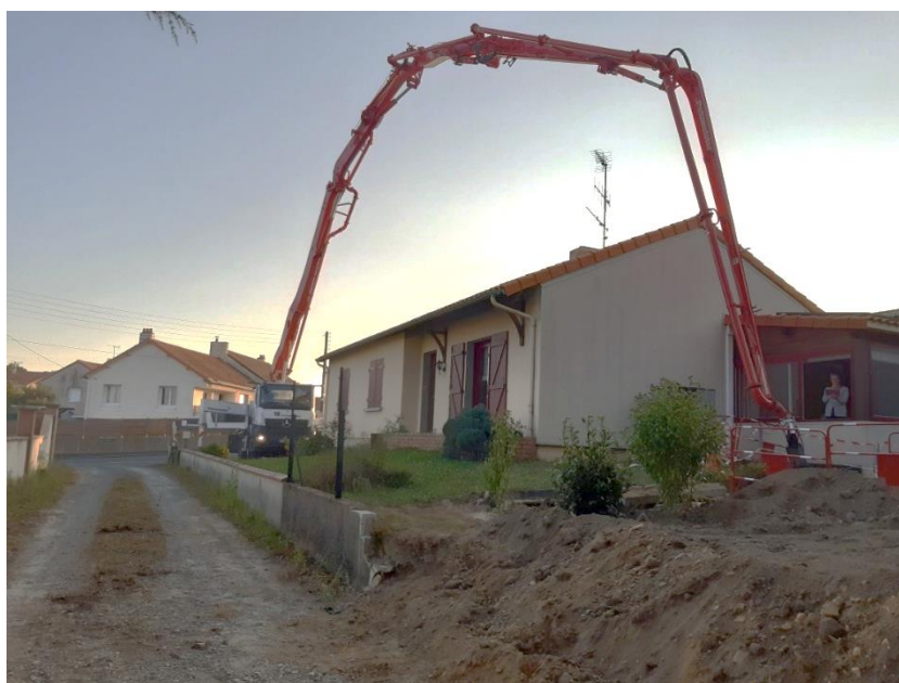
Figure 14 : Bras de distribution articulé lors du coulage
