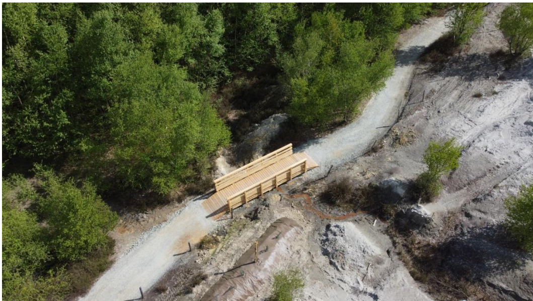
Figure 5 : Exemple de passerelle sur Drainage Minier Acide
