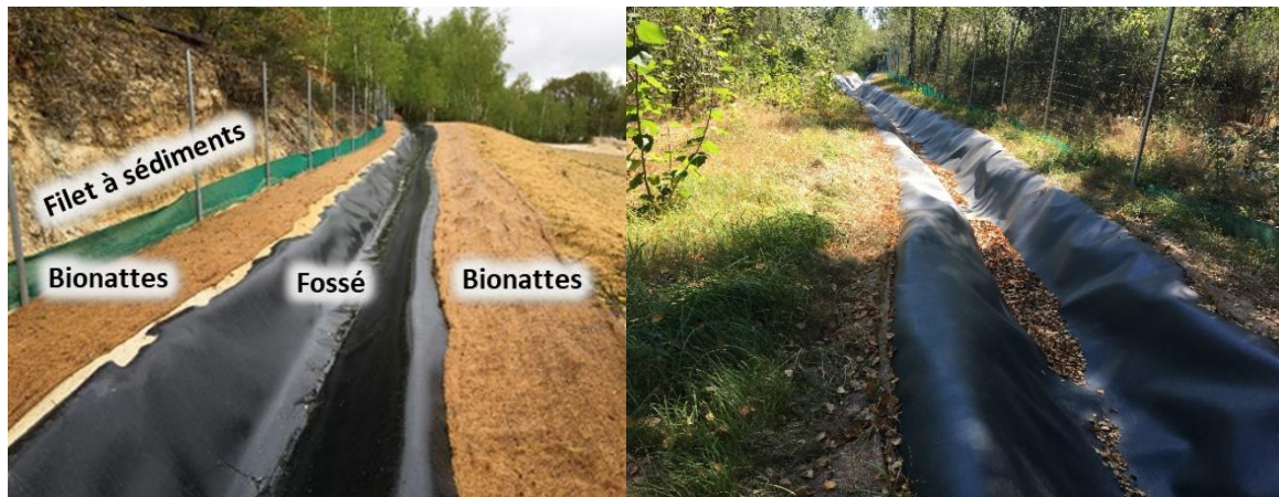
Figure 12 : Dispositifs anti-érosion autour du fossé de contournement des eaux amont (à gauche lors de la pose en avril 2021, à droite en août 2021)
