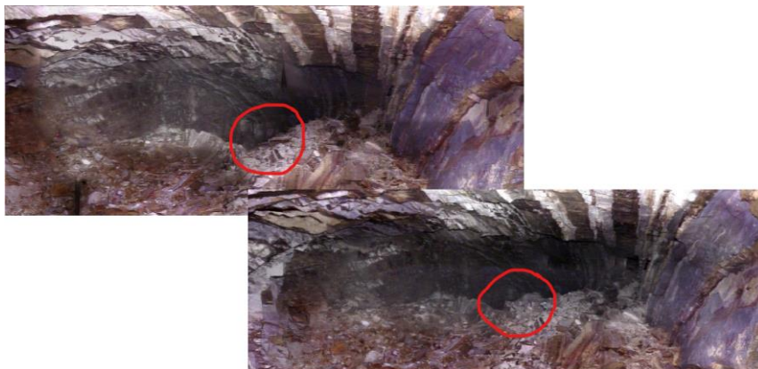
Figure 16 : Observation d'éboulis depuis un des deux forages
