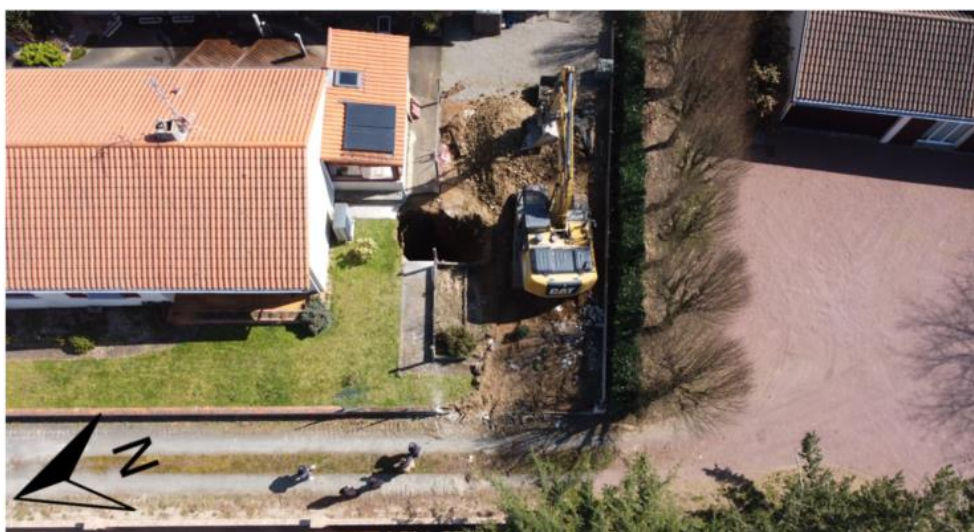
Figure 13 : Travaux d'investigations au droit de la cheminée d'aérage
